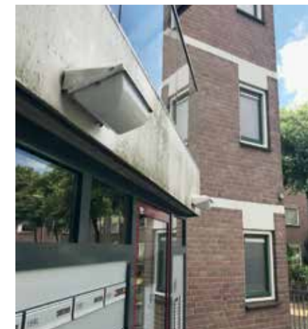
De entrees waren eveneens toe aan een vernieuwingsbeurt. Zo zijn de dakgoten vernieuwd en om een hoger energielabel te verkrijgen is het dak vernieuwd.
