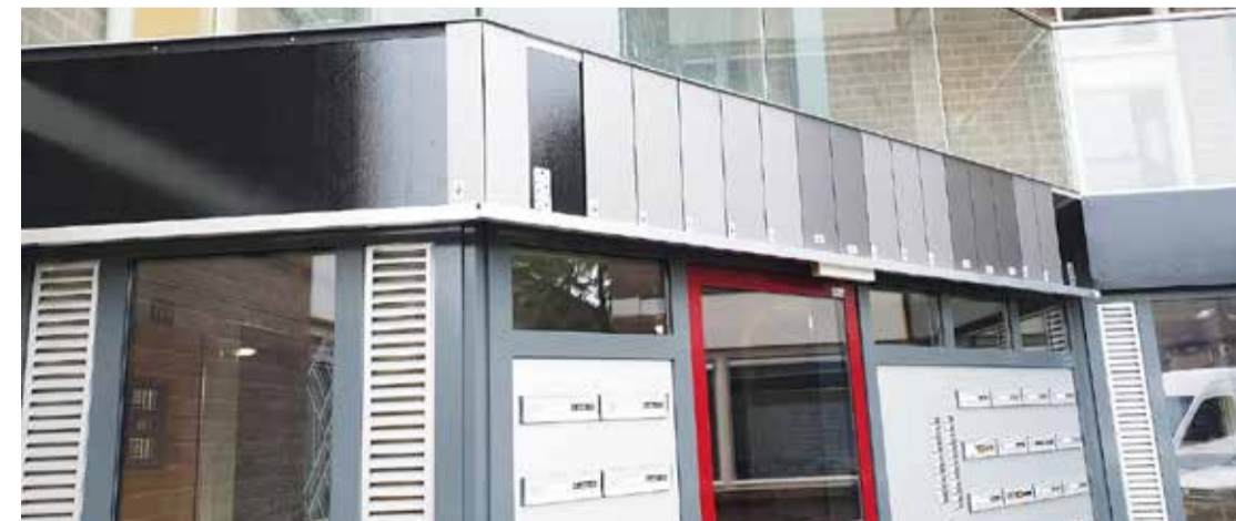
Bijzonder is ook dat een deel van de pv panelen als glas-glas uitgevoerd als proef.
